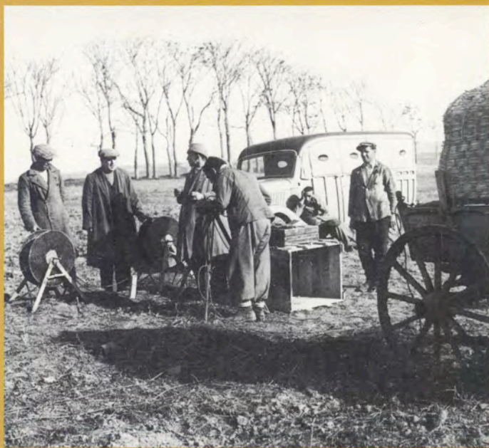
Mesures électriques en Turquie.
